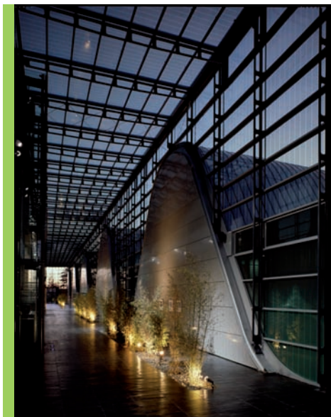
Bâtiment NeuroSpin CEA, architecte Claude Vasconi.
